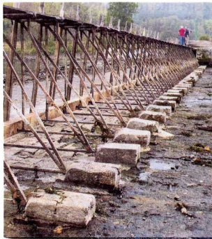
L'opération a consisté à remplacer les longrines en chêne qui supportent les fermes métalliques et les aiguilles du barrage.
