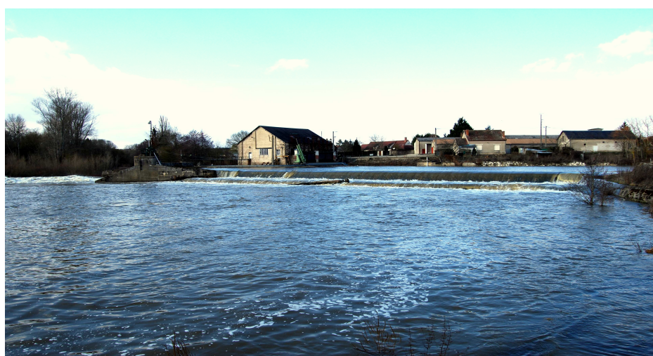
Barrage et usine hydroélectrique de Boutet à Châtres sur Cher
