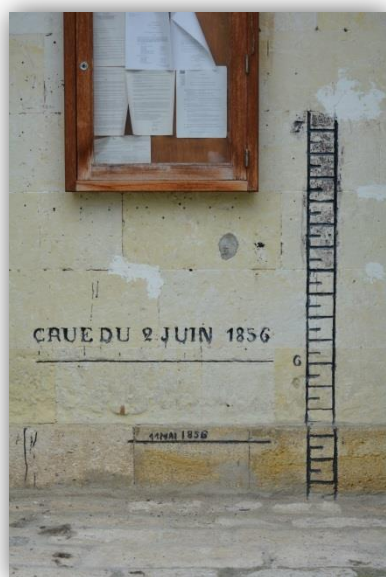
Maison éclusière Bléré
